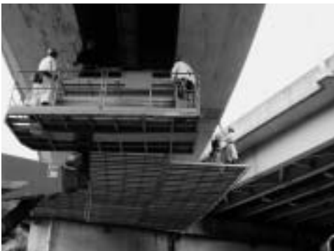
塗装工事中の第5ランプ橋
