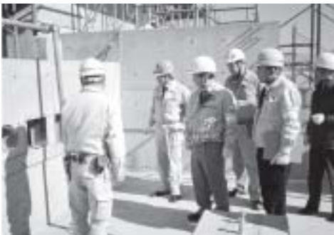
現場において施工状況を細かく確認・調査する組合検査委員
