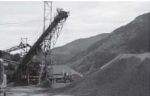
砂利製造現場
