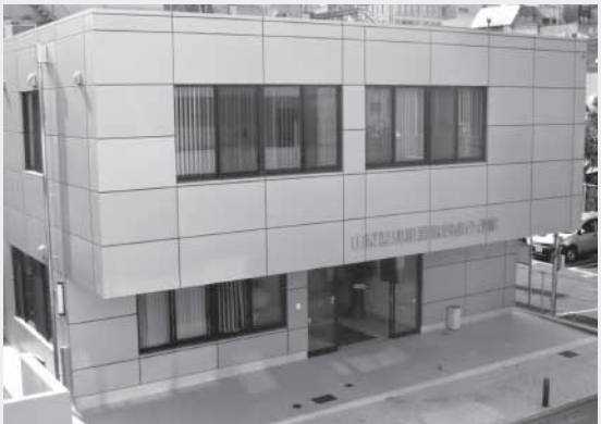
完成した新会館
