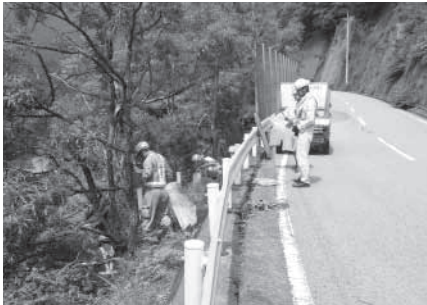
側道添いの急斜面で作業
