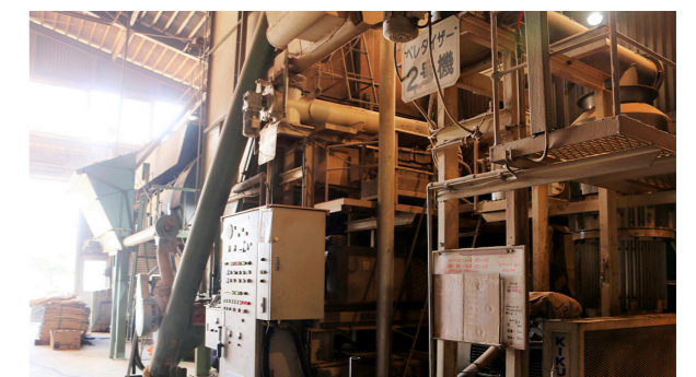
ペレットの製造プラント
