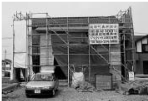
玉穂町で建設中のリサイクル住宅
