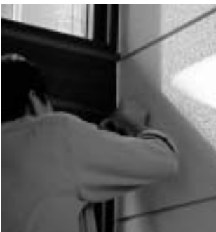
外壁の傾きを調べる診断
