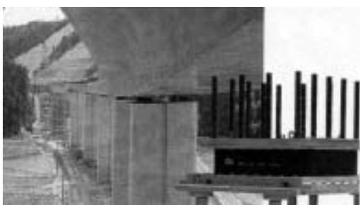
橋梁における免震用積層ゴム
