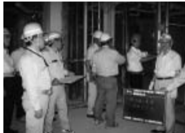
現場での安全パトロールの様子
