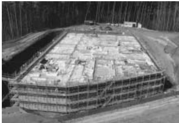
明野廃棄物最終処分場にある浸出水処理施設敷地（調整槽）
