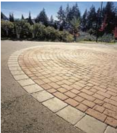
ストリートプリントの施工例
