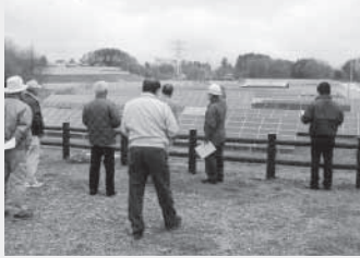
およそ10ヘクタールの土地に設置された太陽電池パネル
