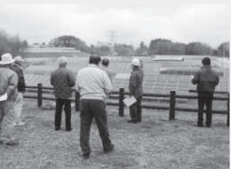
およそ10ヘクタールの土地に設置された太陽電池パネル
