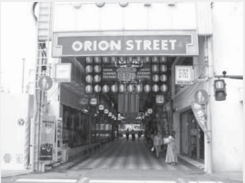
取り壊されたアーケード
