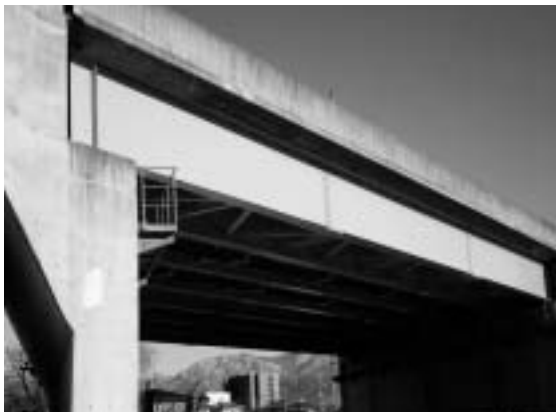
塗り替え工事が完了して竣工を待つ二瀬川橋
