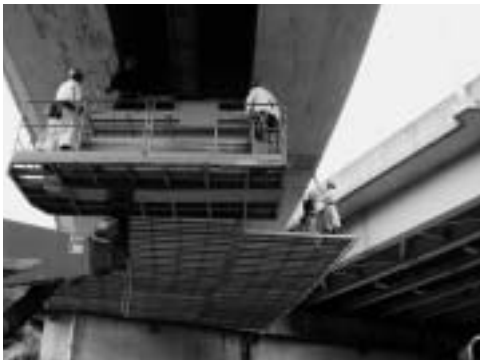
塗装工事中の第5ランプ橋
