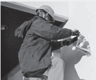
防犯監視カメラの設置作業の様子
