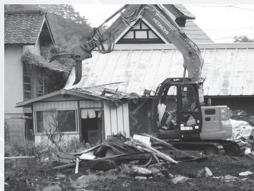
大型重機による撤去作業
