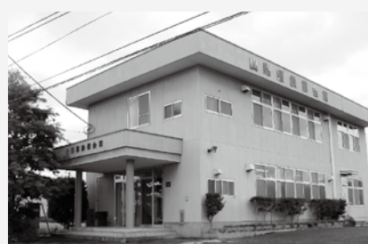
業界の拠点『山梨県鉄構溶接協会』(甲府市大津町)
