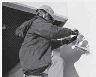
防犯監視カメラの設置作業の様子
