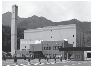
一般廃棄物処理施設 まるたの森グリーンセンター
