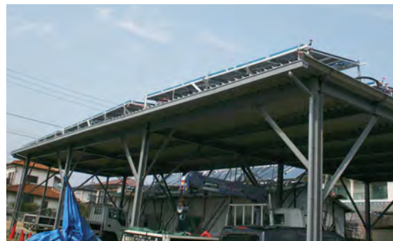
ガレージの屋根が実験場所になっている
