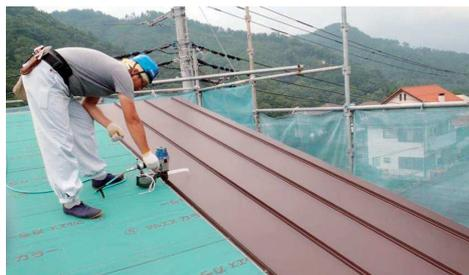
◀ 自社加工した屋根板金を施工中
