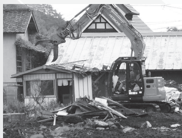
大型重機による撤去作業
