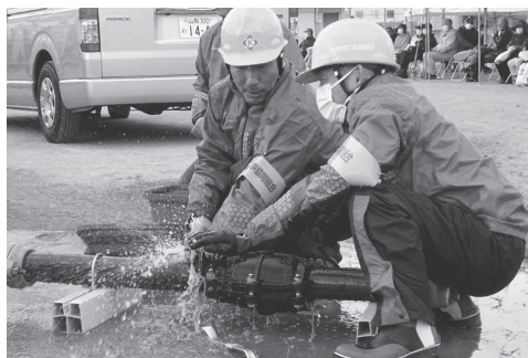
地震による漏水を想定した復旧工事訓練(令和4年)
