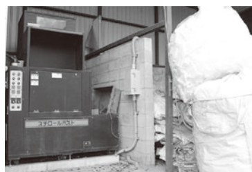
左奥の設備が発砲スチロールの粉碎・溶融施設
