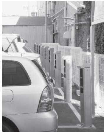
ロック板レス駐車場とカメラポール
